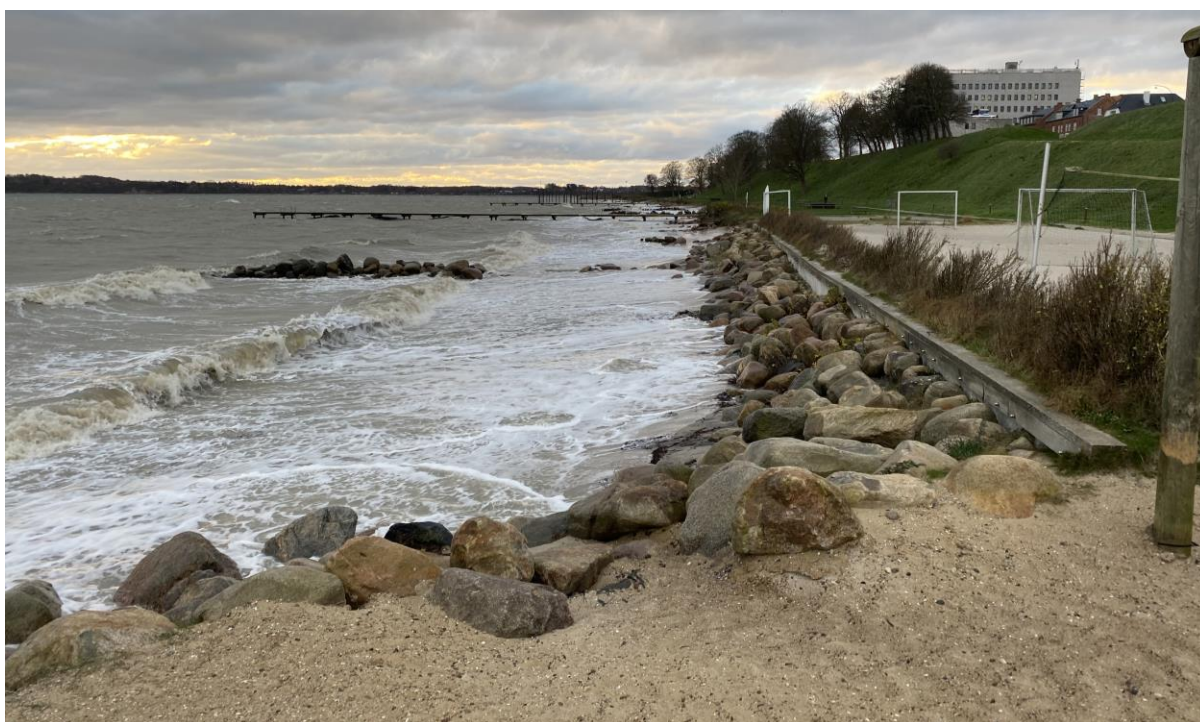
Figur 2-6 Bølger foran skråningsbeskyttelse ved Østerstrand, 17.11.2022
