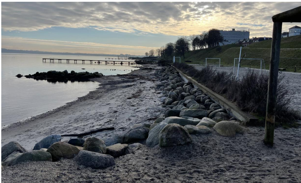
Figur 2-5 Skråningsbeskyttelse ved Østerstrand syd for Cirkelbroen, 25.01.2023
