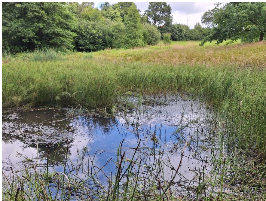
Figur 4: Oversigtsbillede af RB540. Billedet er fra august 2025.
