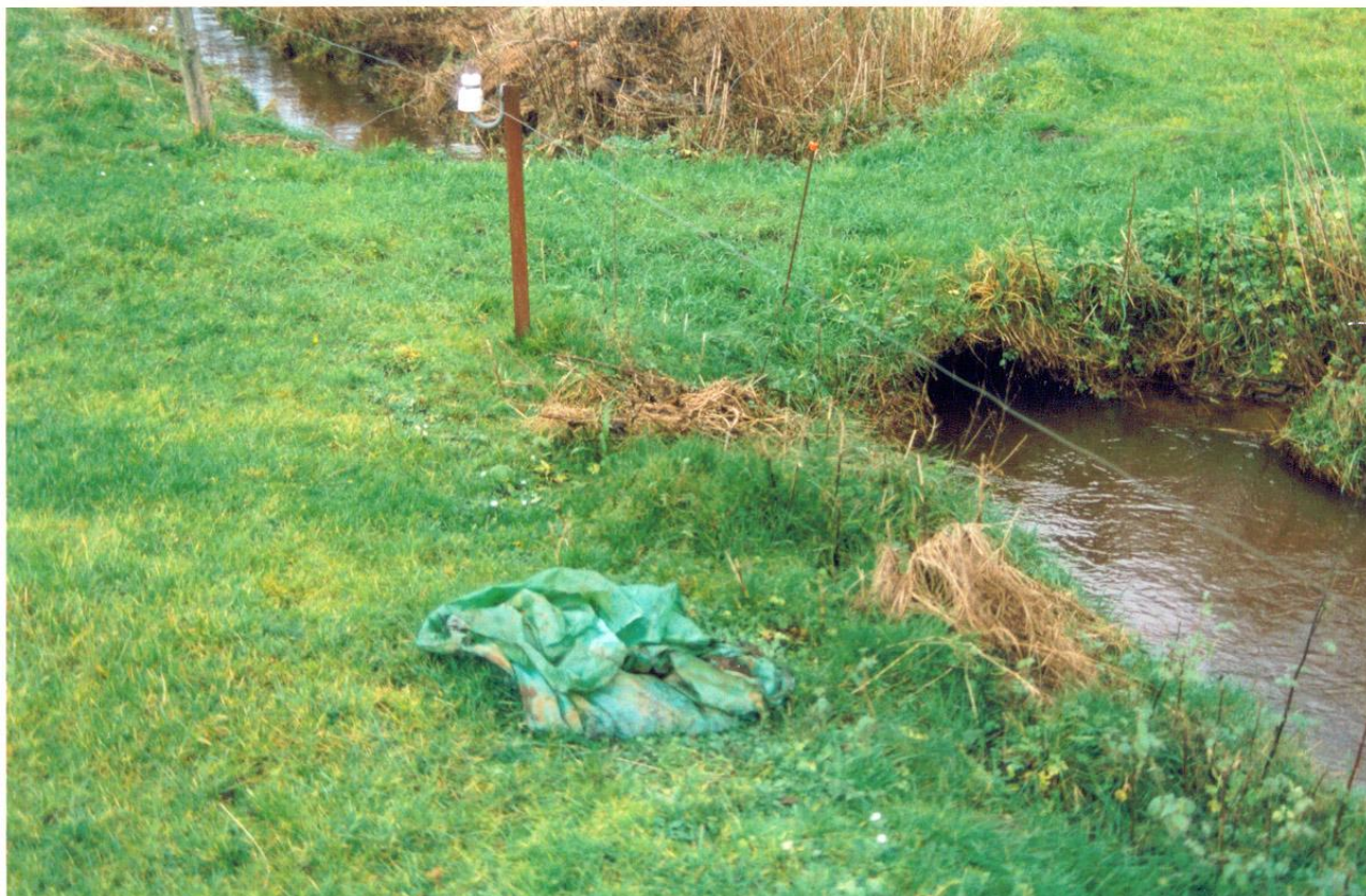
Figur 16. En velanlagt passage over et vandløb, bemærk den høje vandstand i røret, som sikre en tilfredsstillende passage af smådyr og fisk.
