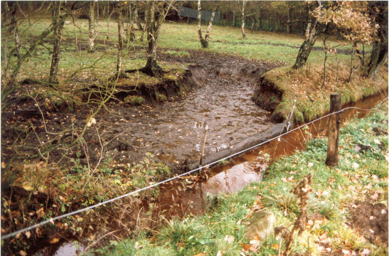
Figur 8. Viser et tilfælde hvor højdeforskellen mellem markens niveau og vandoverfladen i bækken, har været for stor. Dette har medført en stor erosion trods den faste forkant.
