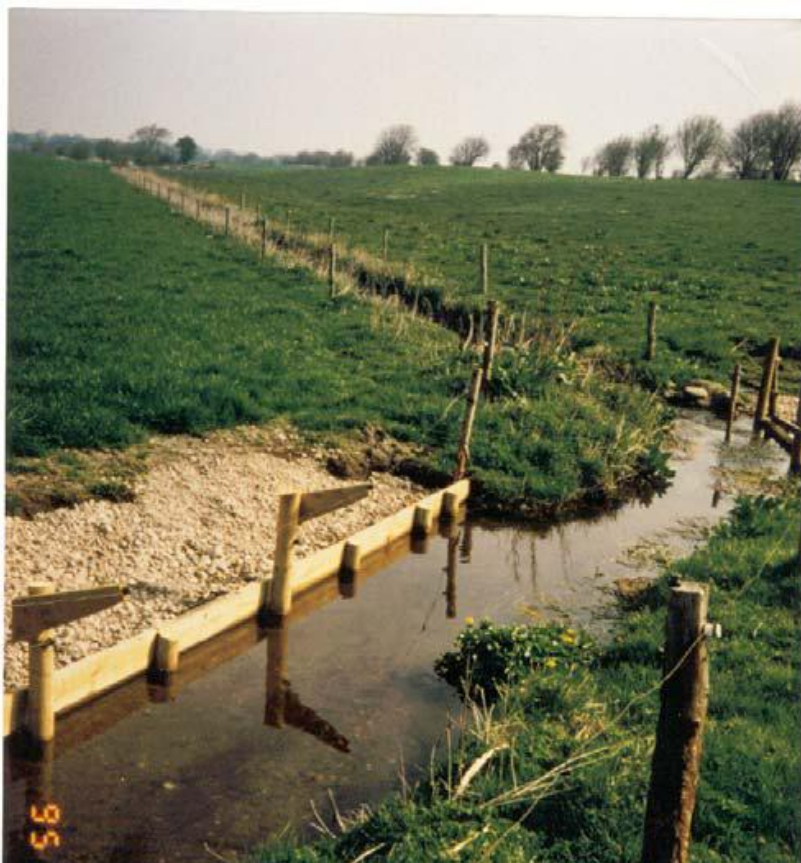
Figur 6. Viser et hensigtsmæssigt udformet vandingssted, med en fast forkant og hvor marken bagved er stabiliseret med udlagt grus.
