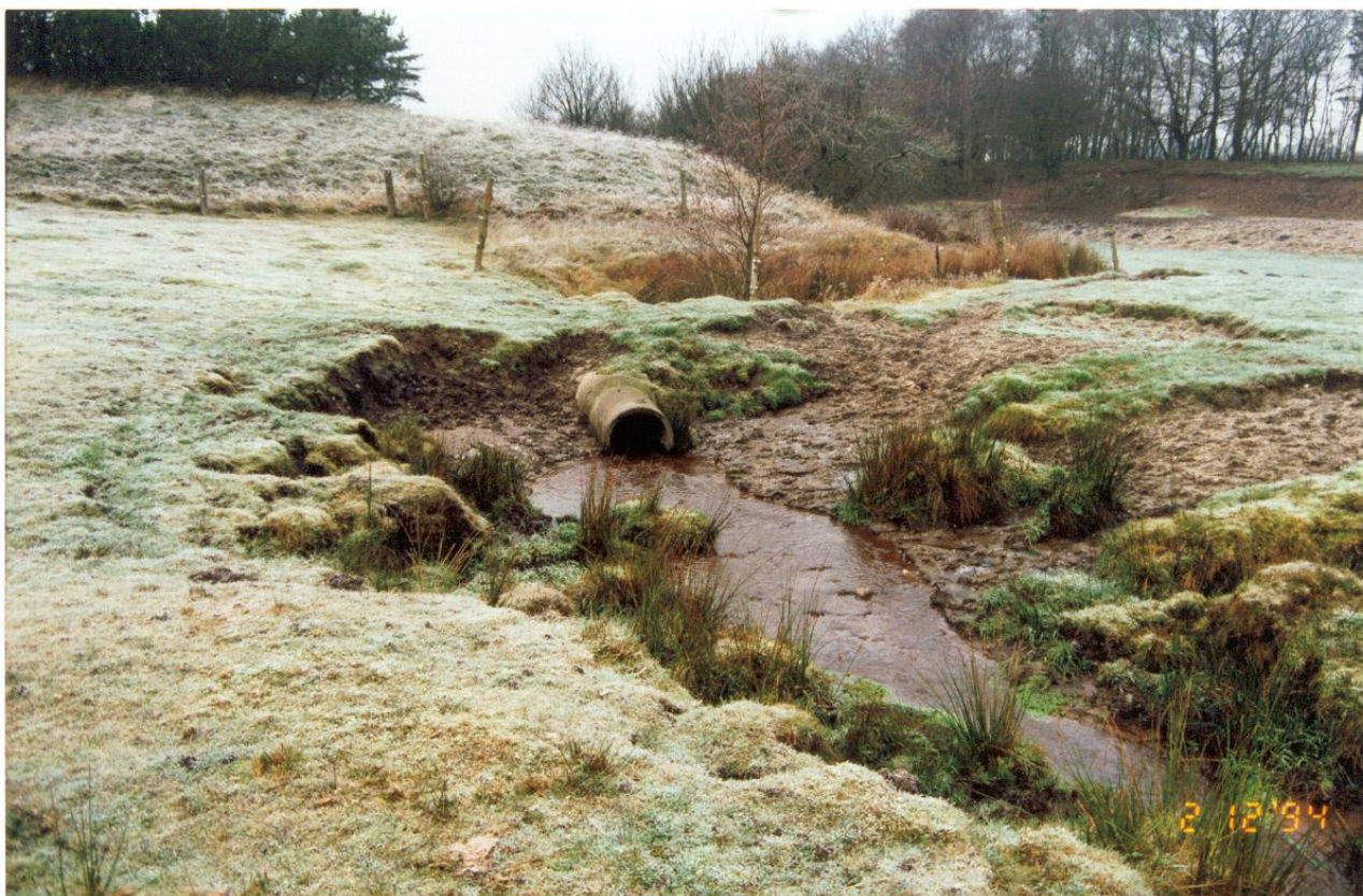
Figur 9. Her har erosion som følge af kreaturernes færden medført et bredt vandløb med lavere vandstand i forhold til røret, på denne måde er der her blevet skabt en selektiv spærring.
