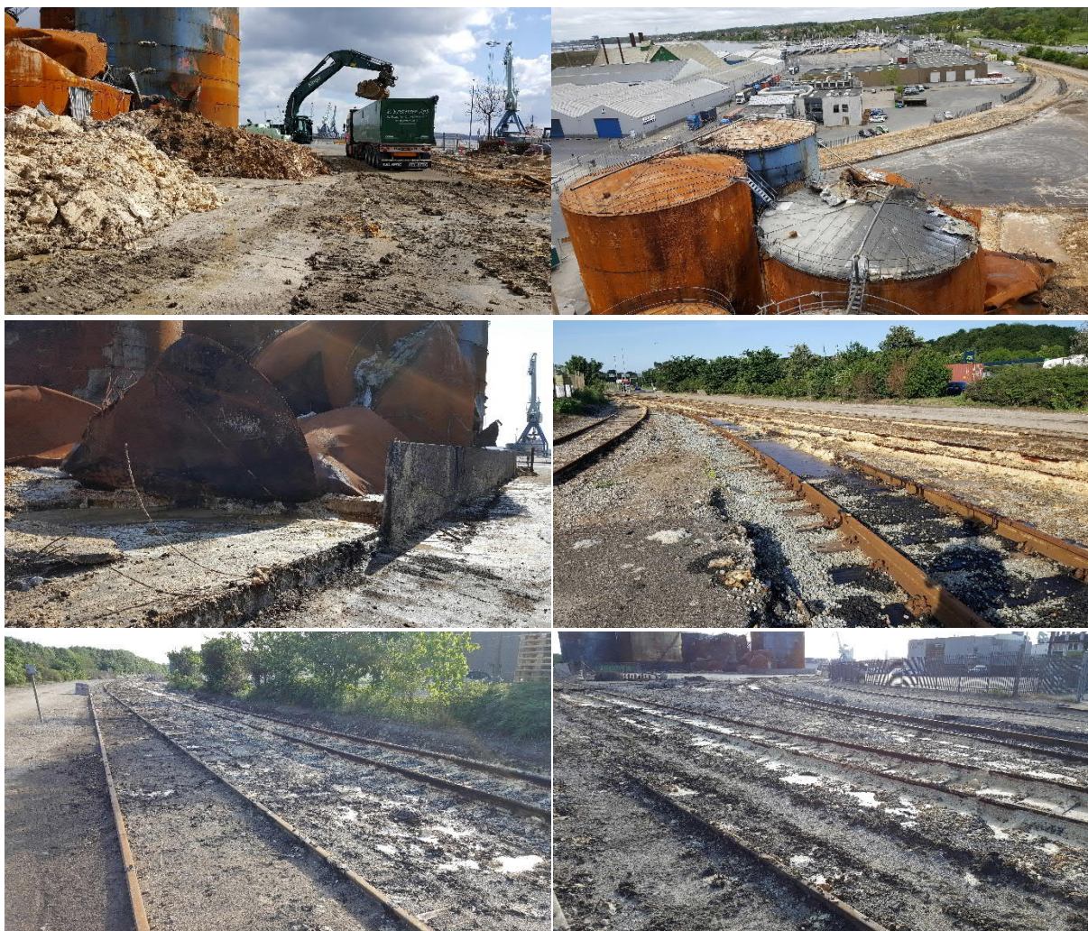
Figur 4.9 Fra oprensningsarbejdet (Foto: Nagro A/S).
