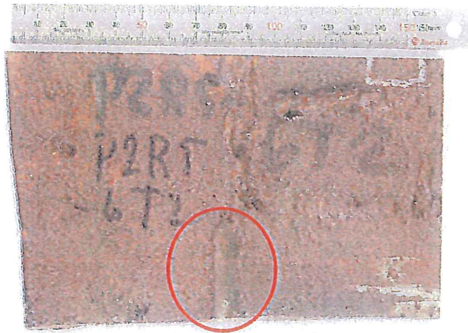
Figur 29 Udsnit af pladestykke 2 med svejsning mellem Rand 5 og 6 set fra indvendig side. Reparations-svejsningen er markeret.
