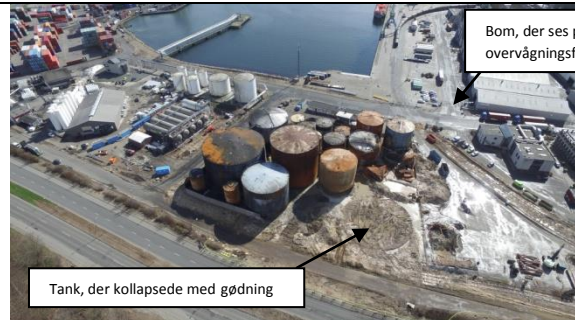
Oversigtskort. Der er ca. 60 meter fra overvågningskameraet til nærmeste kajkant. Der er ca. 140 meter fra centrum af den kollapsede tank til nærmeste kajkant. (foto fra droneoptagelse 8. april 2016)
