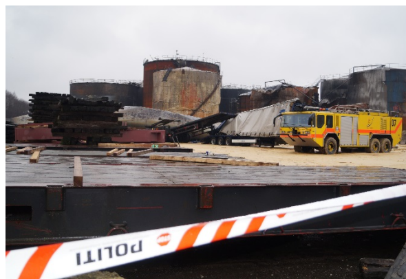
Figur 4.2 Beskadigede tanke umiddelbart efter udslippet.
