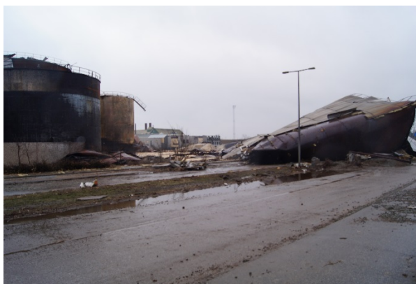
Figur 4.1 Beskadigede tanke umiddelbart efter udslippet (tank 12 ligger på Strandvejen).
