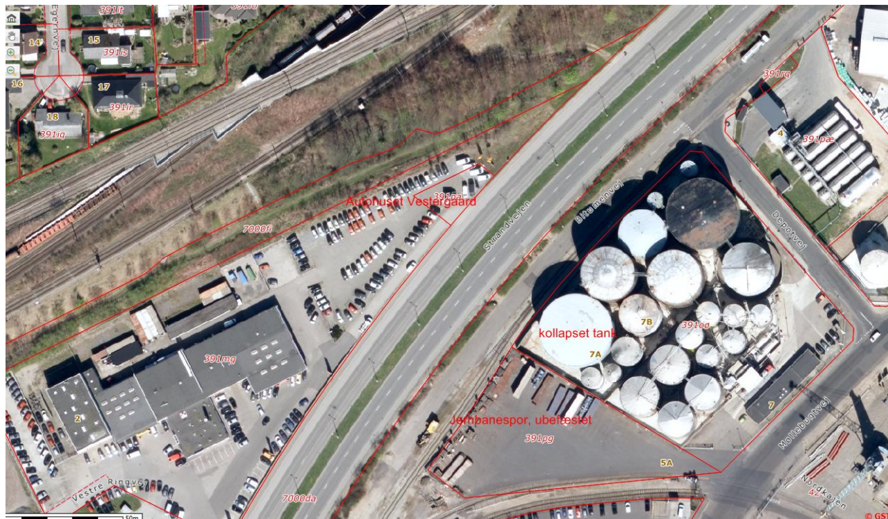
Figur 2. Placering af kollapset tank indeholdende flydende gødning samt tankanlægget hvor også palmeolie opbevares i tanke.
