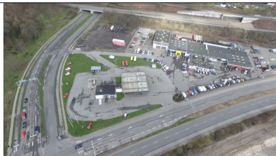
De ubefæstede arealer omkring tankstationen F24 er ikke påvirkede. Svidningen ses tydeligt i midterrabbatten i Strandvejen
