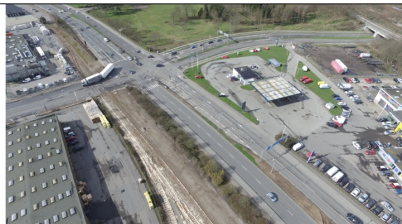
Påvirkning af skinnereale med palmeolie/palmefedtsyrer. Nord for krydset mellem Strandvejen og Nyhavnvej er ikke påvirket.
