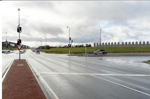
Fotostandpunkt 4 – fremtidige forhold v. krydset Vejle Landevej/Skærbækvej
