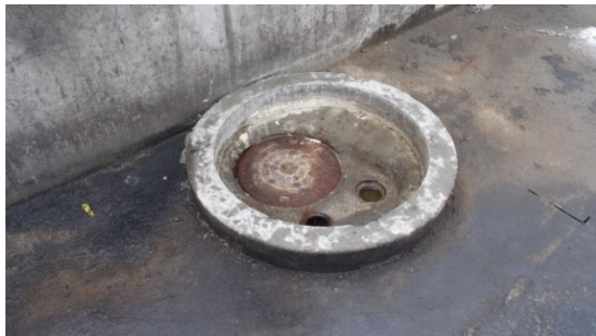
Figur 7: Ekstra brøndring på udløbsbrønd. Møllebugtvej 11
