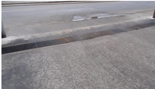
Figur 5: Opkant ved udkørsel fra Møllebugtvej 11
