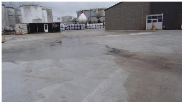
Figur 1: Nyetableret betonbelægning, Møllebugtvej 9
