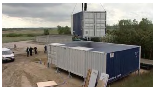
Figur 14.8 Decentral "mini-renseanlæg" fra Grundfos, Biobooster til 5-10 m 3 /h – lave koncentrationer som 77 mg total N/l.
