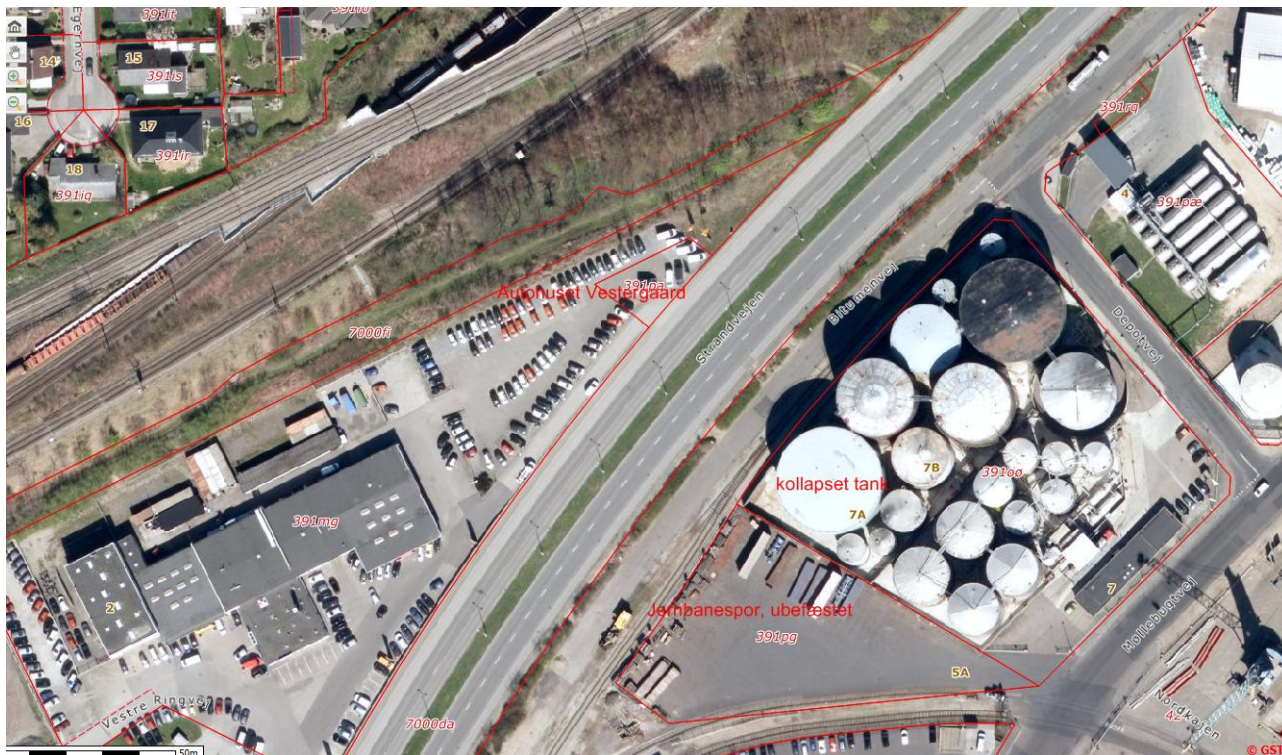
Figur 2. Placering af Kollapset tank indeholdende flydende gødning samt øvrige tanke på ejendommen.
