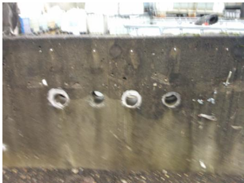
Figur 1: Huller i tankgård på Møllebugtvej 9
