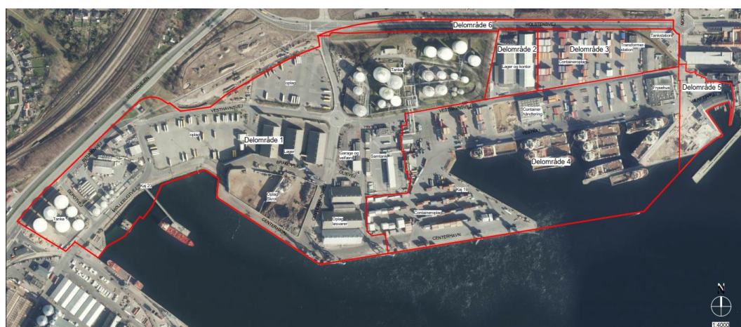
Figur 1-2: Eksisterende forhold. Centerhavn med kaj 23 til venstre og Vesthavn med kaj 19 til højre.
