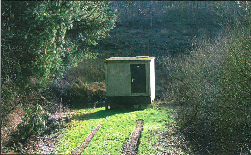
Boring på Elbo Kildeplads
