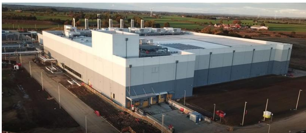
Figur 3-3 billede af det eksisterende datacenter.
