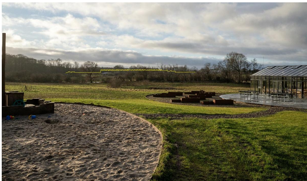
Figur 14-17. Eksisterende tilstand og visualiseret fremtidig tilstand fra fotostandpunkt 5. Billedet er taget fra et boligområde, ca. 1 km fra projektområdet. Datacentret er ikke synligt på grund af beplantning, men er her markeret med en gul silhuet.
