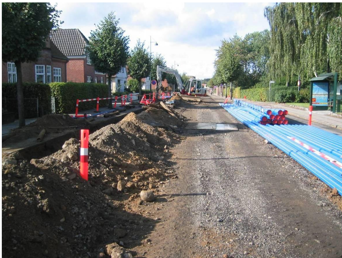
Ledningsarbejde (Foto: Grontmij | Carl Bro)
