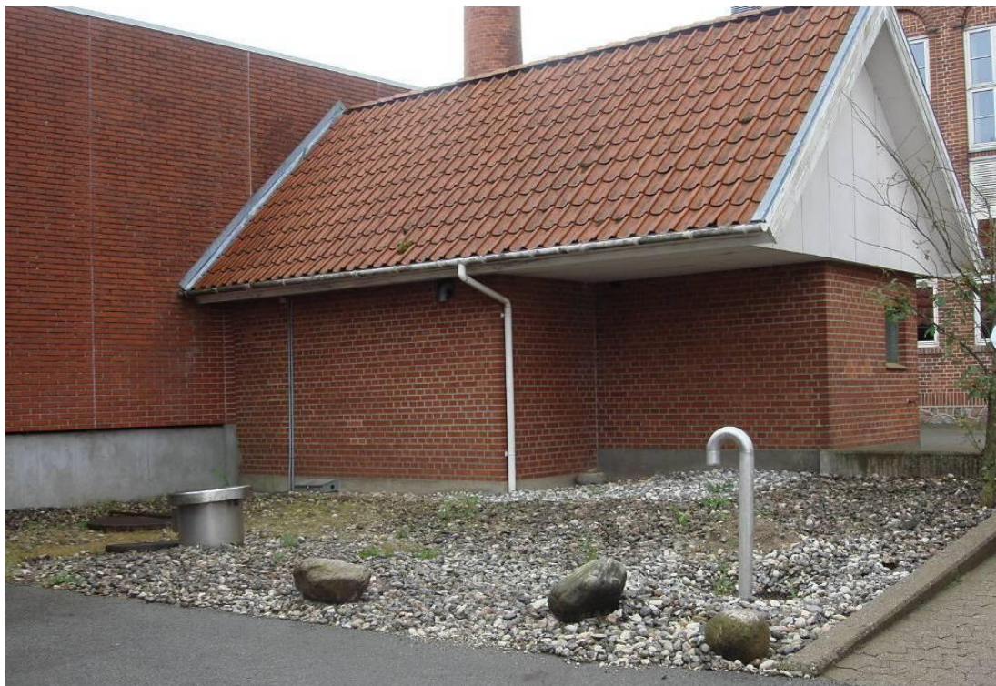
Vandværk hos Arla – Højrupvej 116 (Foto: Fredericia Kommune)
