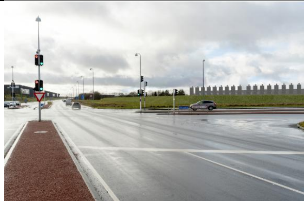
Fotostandpunkt 4 – fremtidige forhold v. krydset Vejle Landevej/Skærbækvej
